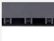
Lüftungsschlitze für den Austritt von Kondenswasser
