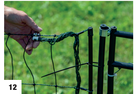
12 Netzverbindungsklemme außerhalb des Durch- gangsbereiches befestigen Attach the net connection clamp outside the passage area Fixez la pince de connexion du filet à l'extérieur de la porte
