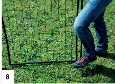
8 Eintreten des Torpfahls, um den das Tor schwenkt Pushing the gate post into the ground around which the gate pivots Enfoncez dans le sol le poteau pivotant du portail
