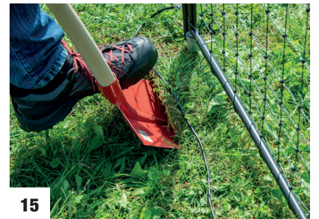
15 Eingraben des Erdkabels. Achtung: Erdkabel in einem Schutzrohr verlegen Burying the underground cable. Attention: Lay the underground cable in a protective tube Enfouissez le câble souterrain. Attention : Posez le câble souterrain dans une gaine de protection
